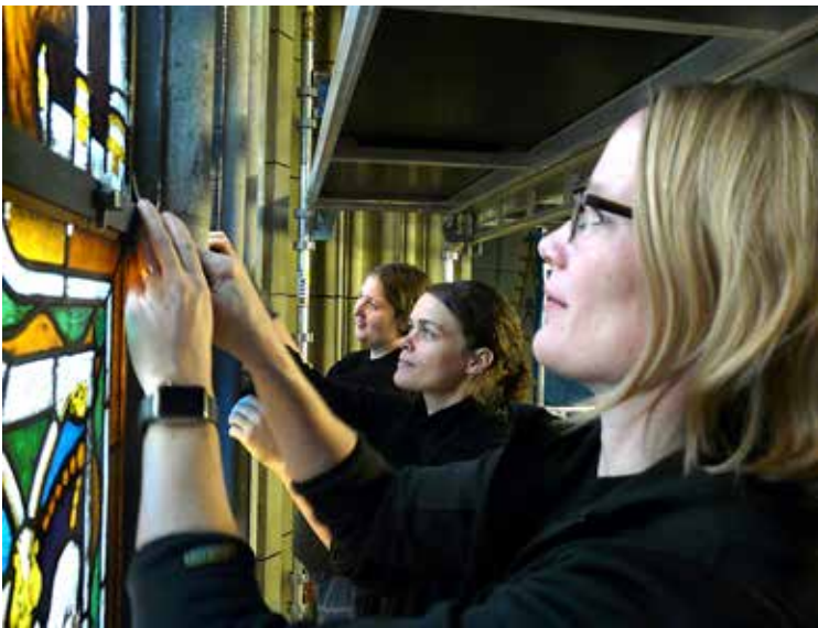
Sista panelen på Sonens fönster i Uppsala domkyrka sätts på plats. FOTO: HENRIK VIBERG
